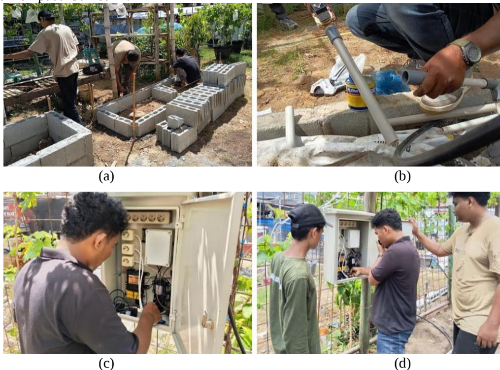
Gambar 4. Tahapan implementasi sistem di lapangan: (a) penyiapan bedengan; (b) perakitan jaringan distribusi; (c) pemasangan panel kendali; dan (d) pemeriksaan unit kontrol.
