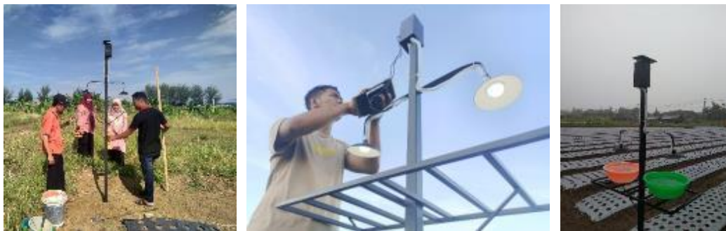
Gambar 2. Pemasangan Alat PLT di lahan budidaya
